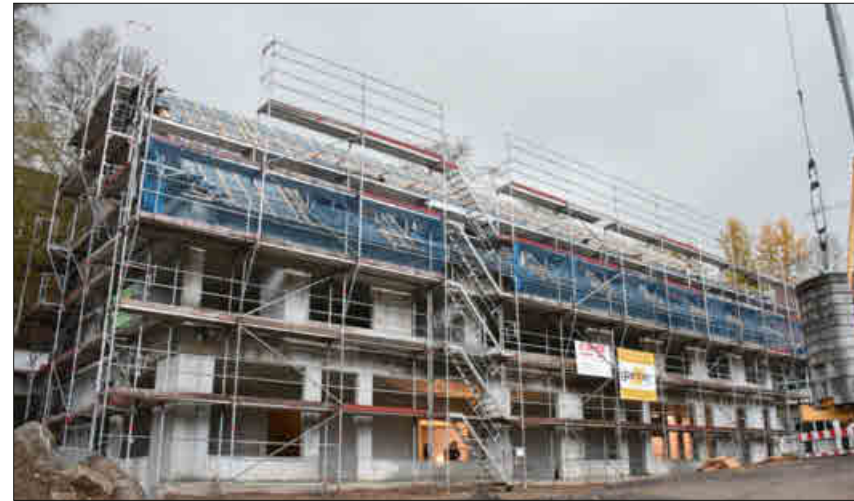
Auf dem Gelände des Birklehofs entsteht ein neues Gebäude mit zwei Klassenräumen, neun Doppelzimmer für Internatsschüler und zwei Mitarbeiterwohnungen. Jetzt konnte Richtfest gefeiert werden. FOTO: THOMAS BINIOSSEK
